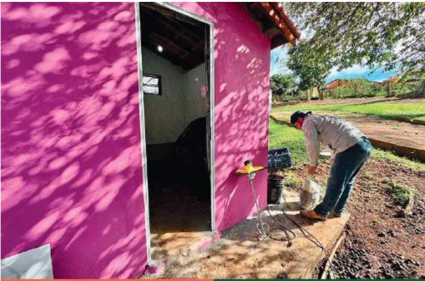
Reforma do banheiro da Padaria Municipal
