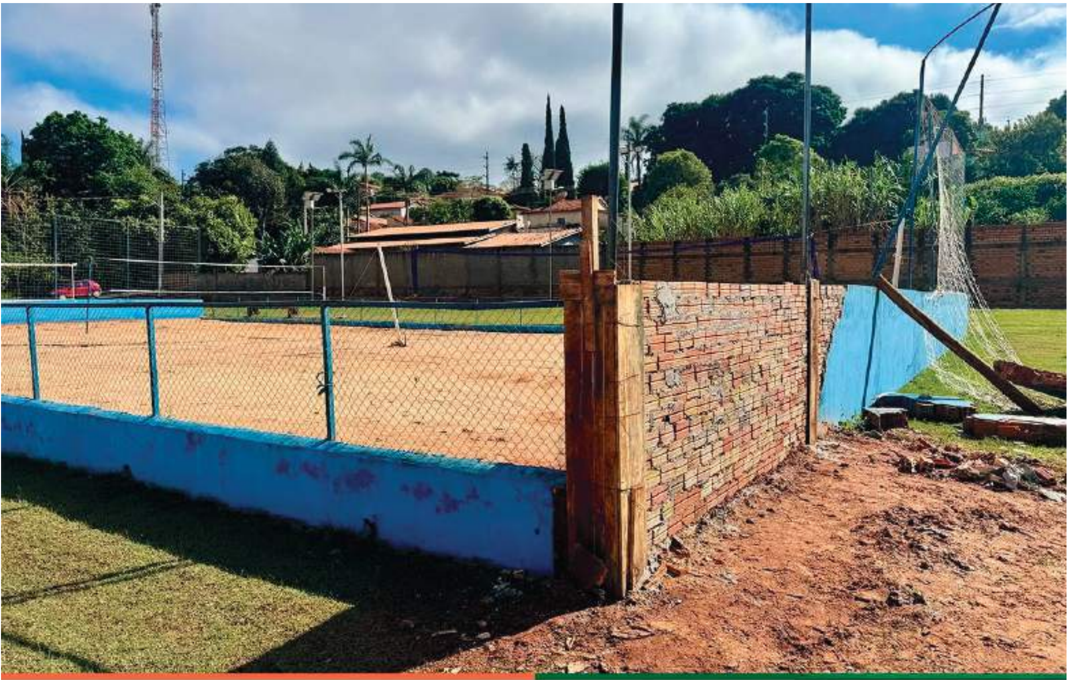
Recuperação do muro e melhorias no campo do Complexo Esportivo
