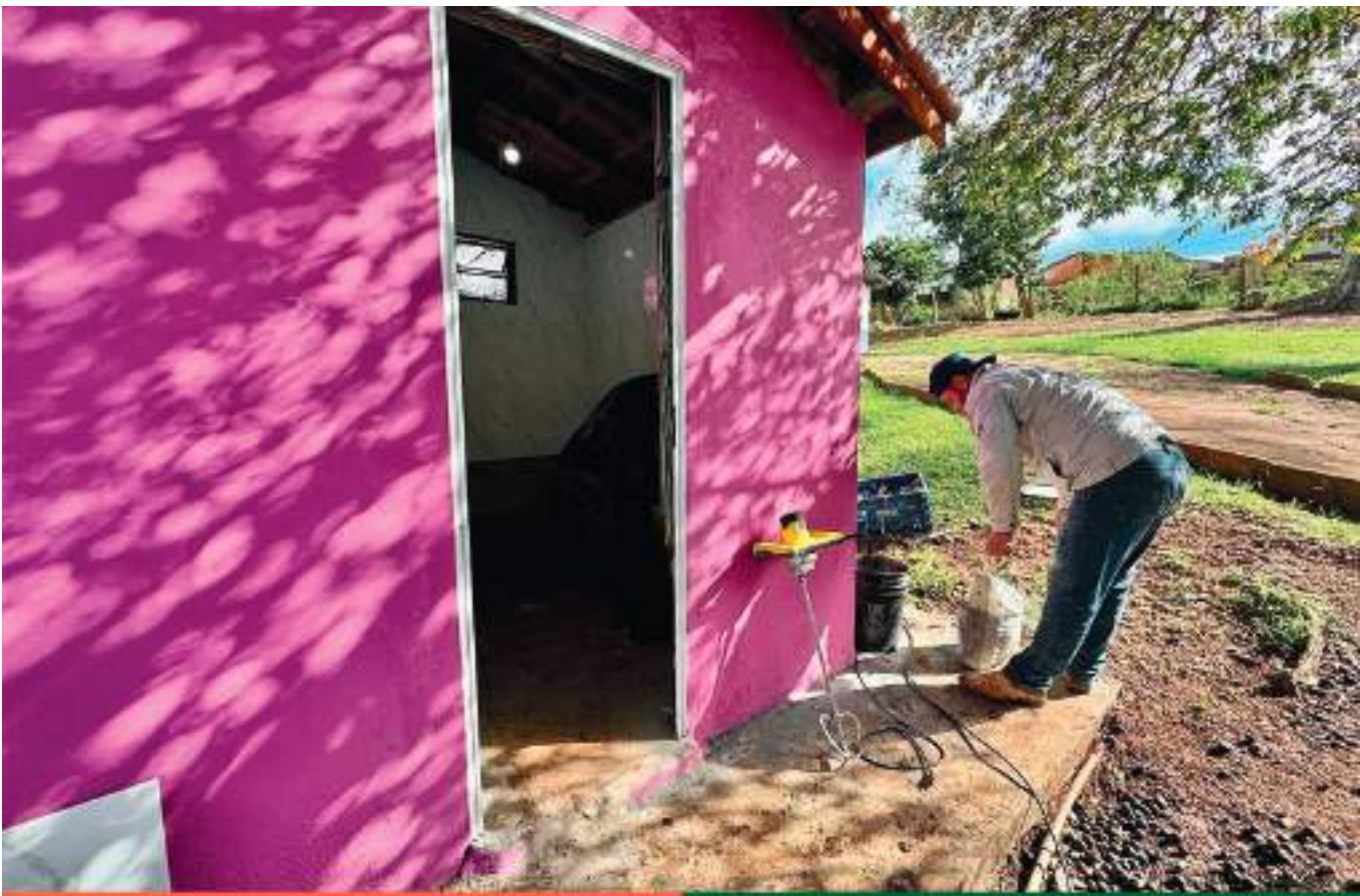
Reforma do banheiro da Padaria Municipal
