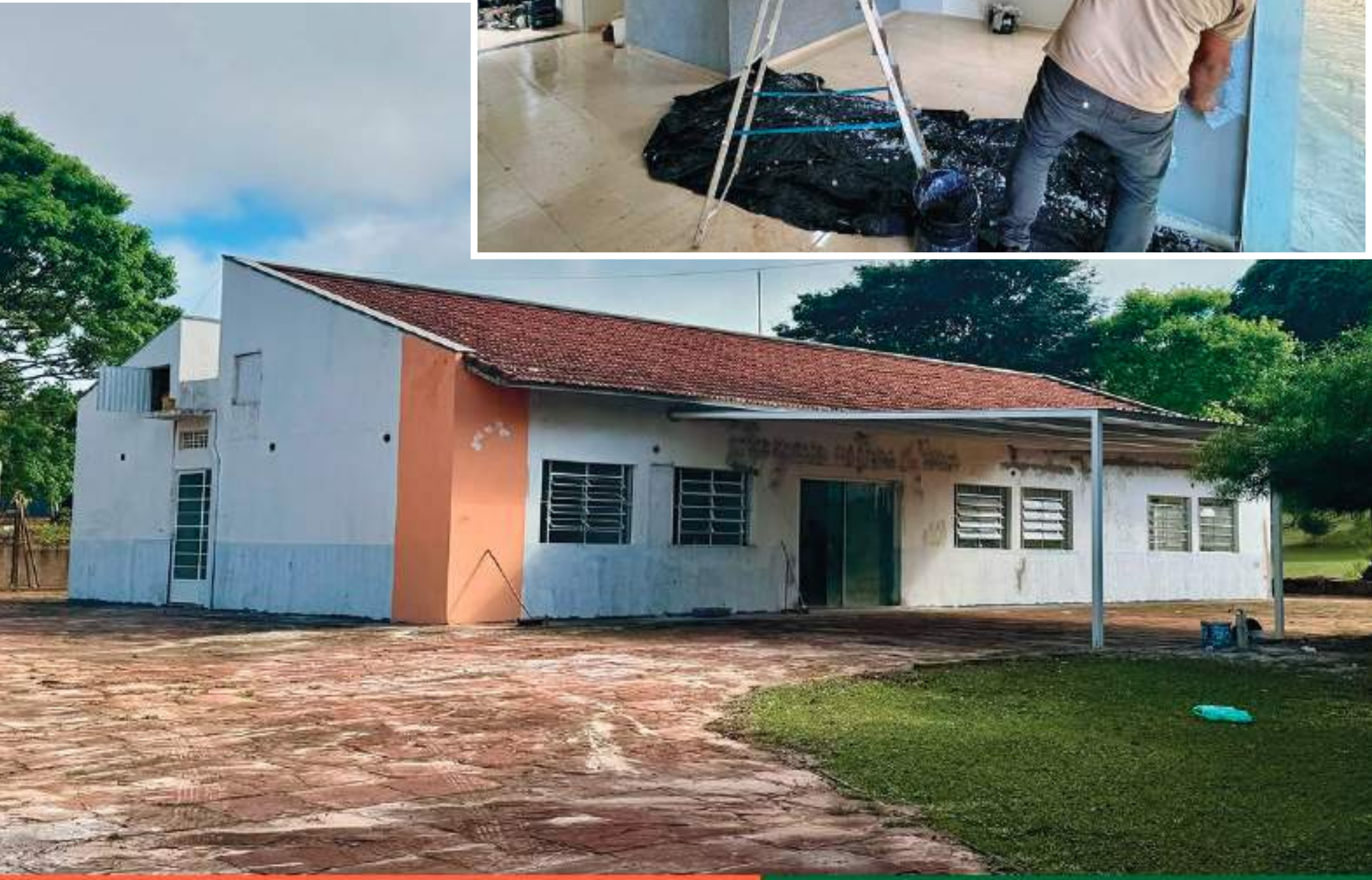
Novo prédio do ESF no Teto
