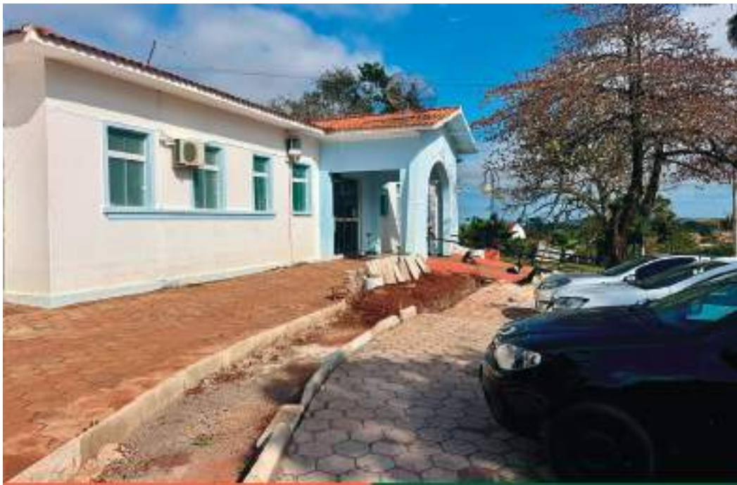
Estacionamento e piso com acessibilidade no Centro de Saúde
