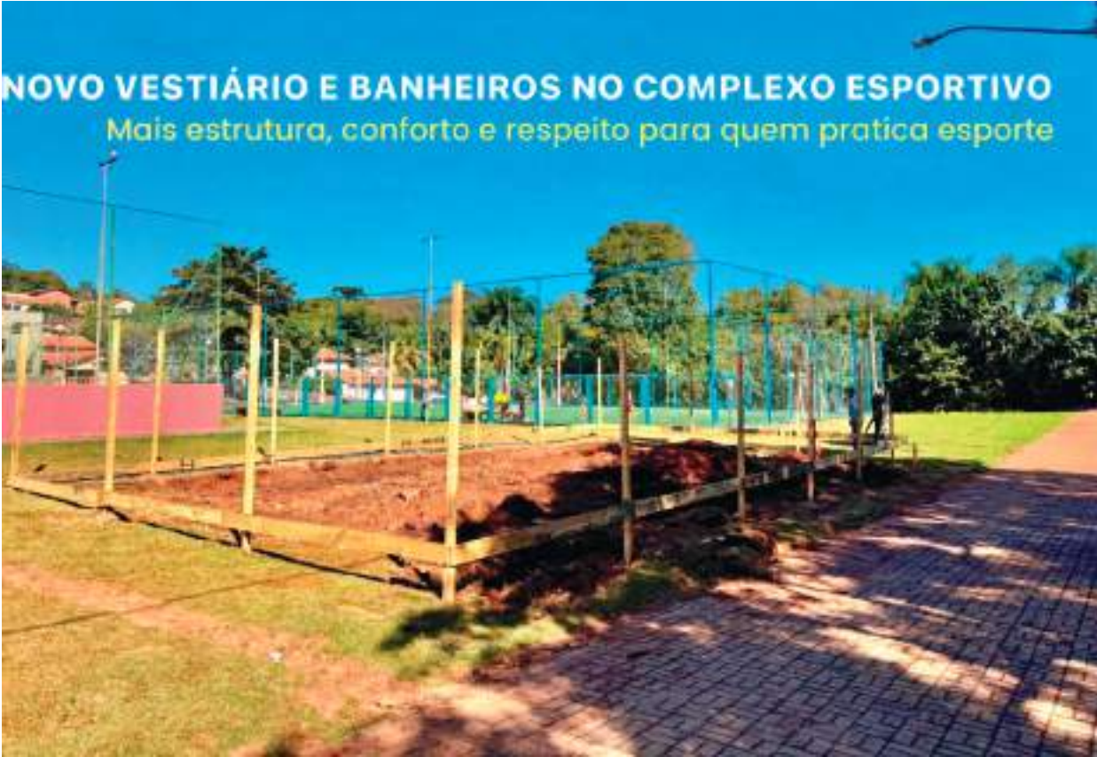
NOVO VESTIÁRIO E BANHEIROS NO COMPLEXO ESPORTIVO Mais estrutura, conforto e respeito para quem pratica esporte
