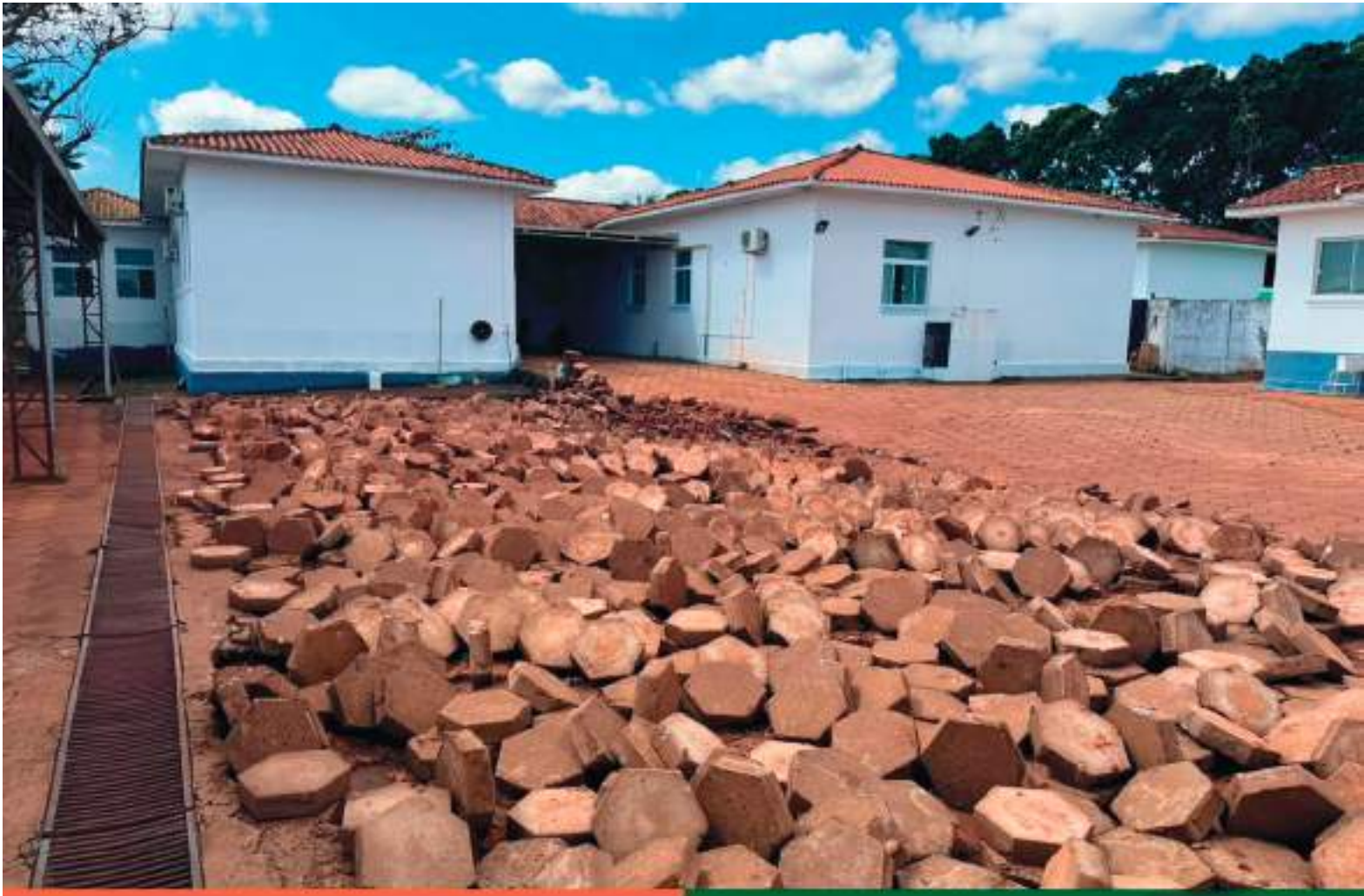
Será construído novo piso no estacionamento de veículos do Centro de Saúde
